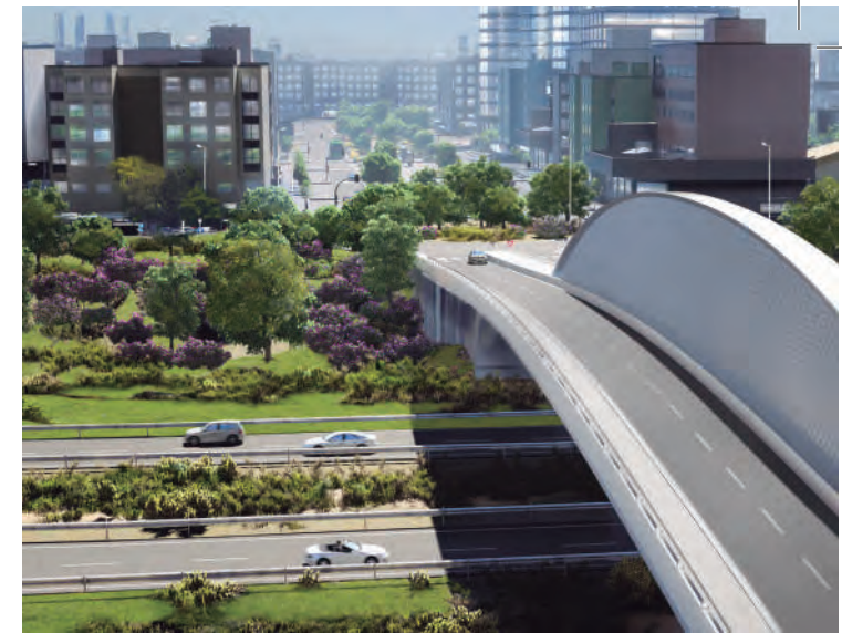
Puente que une Valdebebas con la T4 del Aeropuerto Madrid-Barajas.
