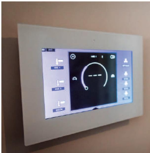
**Control domótico de aire acondicionado.** Control en remoto desde aplicación web del fabricante, smartphone y otros sistemas de control de hogar como google Home o Alexa. Control on/off de la instalación y control de temperatura general.
