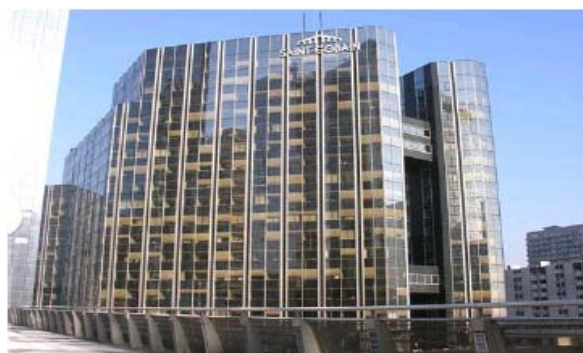
Torre de oficinas "Miroirs" 18 Quai D'Alsace (Paris)
