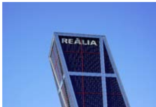
Torre Realia The Icon: Conmutación de grupos electrógenos Segunda fase de reforma de aseos (plantas 7, 15 y 21)
