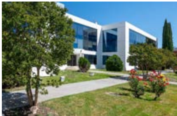
Musgo 3: Sustitución de bomba de calor
