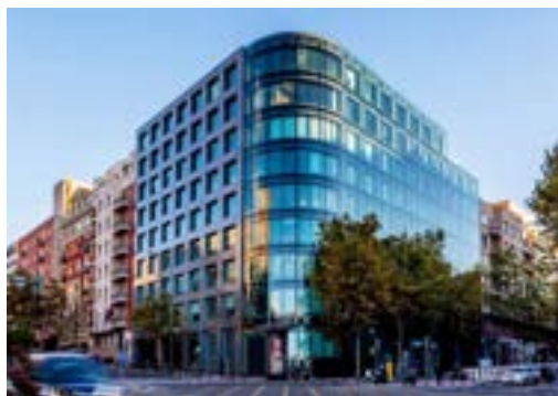
María de Molina 40: - Sustitución de torres de refrigeración - Impermeabilización de la cubierta.
