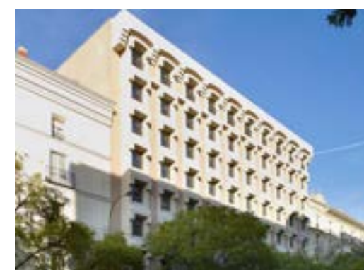
Goya 29: Impermeabilización de la cubierta.
