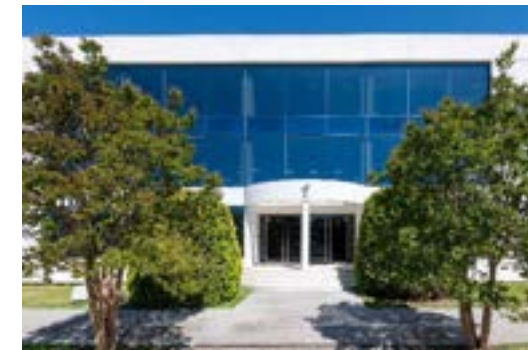
Musgo 1: Sustitución de bomba de calor y climatizador. Finalización de la reforma integral.
