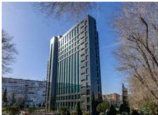
Salvador de Madariaga: Nueva pista de pádel (1ª fase) Comienzo actuaciones para cambio de torres de refrigeración.
