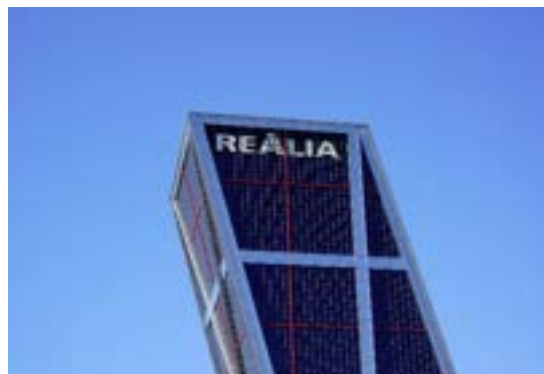
Torre Realia The Icon: Conmutación de grupos electrógenos Segunda fase de reforma de aseos (plantas 7, 15 y 21)
