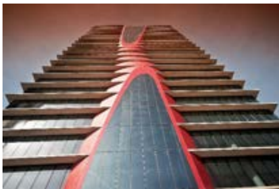
Torre Realia Barcelona: Reforma de vestíbulos de ascensores (plantas 1ª a 12ª).
